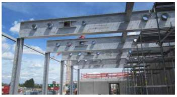
Sporthalle in den Brückentragwerken wurden deshalb auf dynamische Belastungen (Schwingungen) überprüft.
